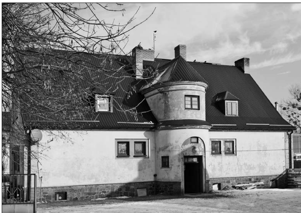
Elewacja południowa jednego z budynków przy ulicy Słowackiego. Klatka schodowa z półokrągłym ryzalitem. Fot. Andrzej Bigus
