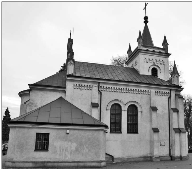
Kaplica cmentarna św. Jakuba. Elewacja zachodnia, stan z 2015. Fot. autor
