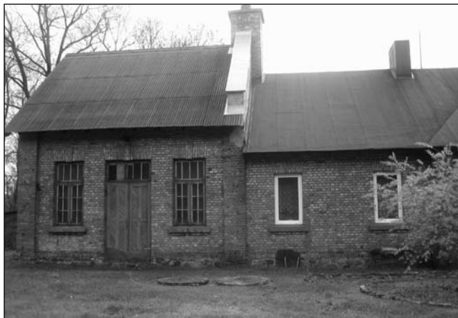
Przepompownia kolejowa w Gostyninie. Stan obecny. Fot. autorka
