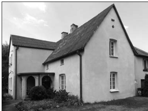
Willa Żylińskich przy ul. 18 Stycznia 35. Stan z 2015 r. Fot. Maria Ziętek
