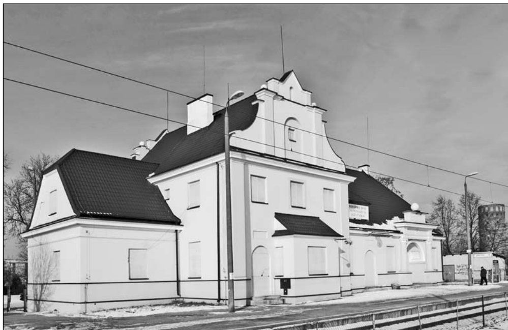
Budynek dworca od strony torów kolejowych, stan z 2016 r. W głębi wieża ciśnieniowa. Fot. Andrzej Bigus
