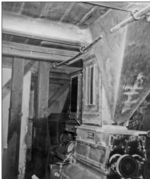
Wnętrze młyna w Białotarsku, młewnik. Obok fragmenty wietrznika i podnośnika. Fot. zbiory rodzinne Błażeja Wasiaka
