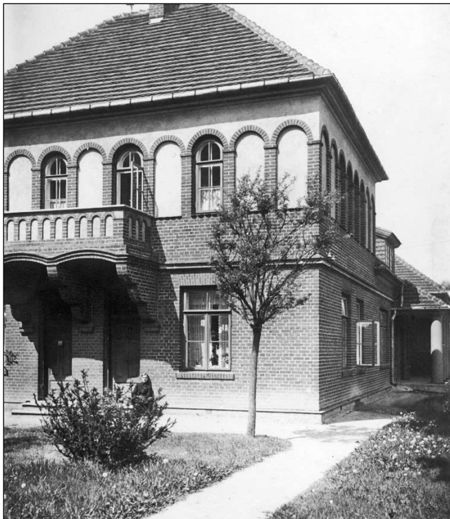
Budynek plebanii wybudowany przez ks. Edwarda Szczodrowskiego. Fot. archiwum parafii św. Marcina w Gostyninie
